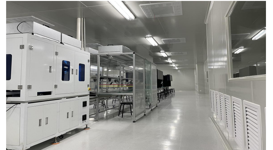
自動組立ライン Clean room:class1000
